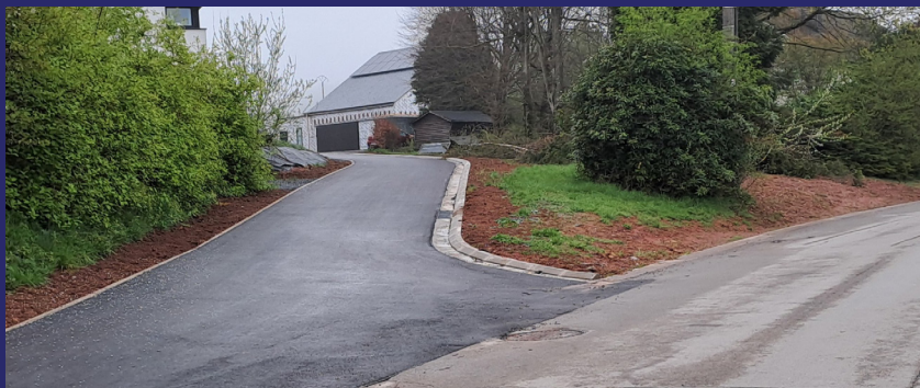
Rénovation du Chemin des Campinets à Libin
