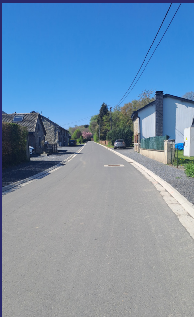
Rénovation de la rue Batti du Foy à Anloy avec remplacement de la conduite d'eau et de l'égouttage
