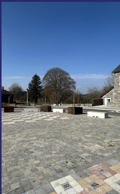
Aménagement de la place de Glaireuse, en ce compris la rénovation du réseau d'eau
