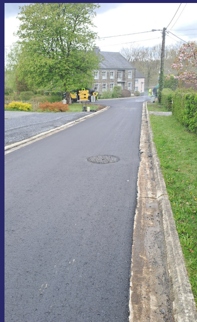
Rénovation du quartier de Hamaide à Redu avec la pose d'un égouttage
